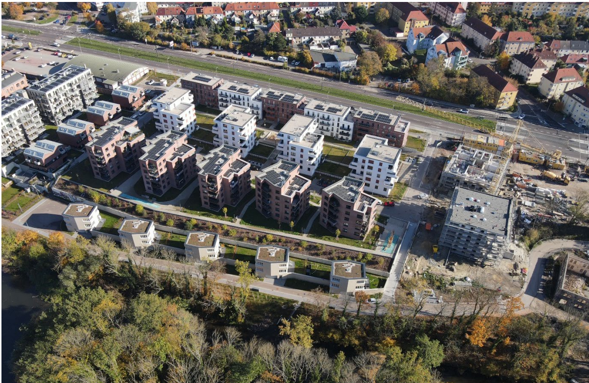
Luftbild des neuen Wohngebietes „Am Mühlwerder“. Rechts im Bild sind die zwei im Bau befindlichen Mehrfamilienhäuser zu sehen, in denen die 34 Wohnungen entstehen. Foto: GWG Halle-Neustadt/ Maik Preißer
